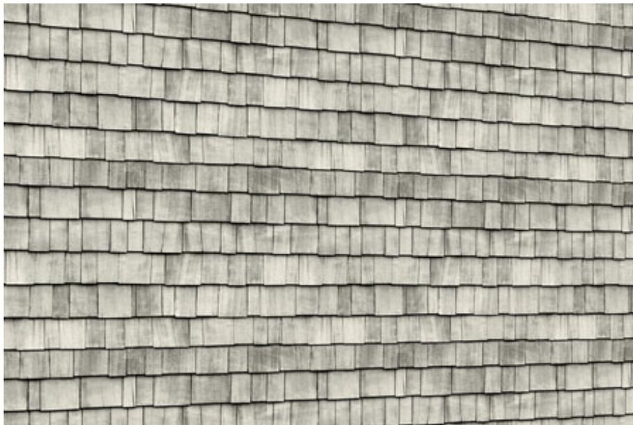
Faits de ciment, sable, fibre cellulosique et minéraux, les bardeaux sont formés de plaques de 1/4 po d'épaisseur, pour 18 po de longueur et 6 à 12 po de largeur, disposées en couches superposées sur le cadre extérieur. Ils sont généralement cloués au revêtement par-dessus une couche de pare-vapeur. Convient à des éléments de murs extérieurs tels que de nombreuses ouvertures et formes de coins, fenêtres et portes, typiques des maisons haut de gamme.
