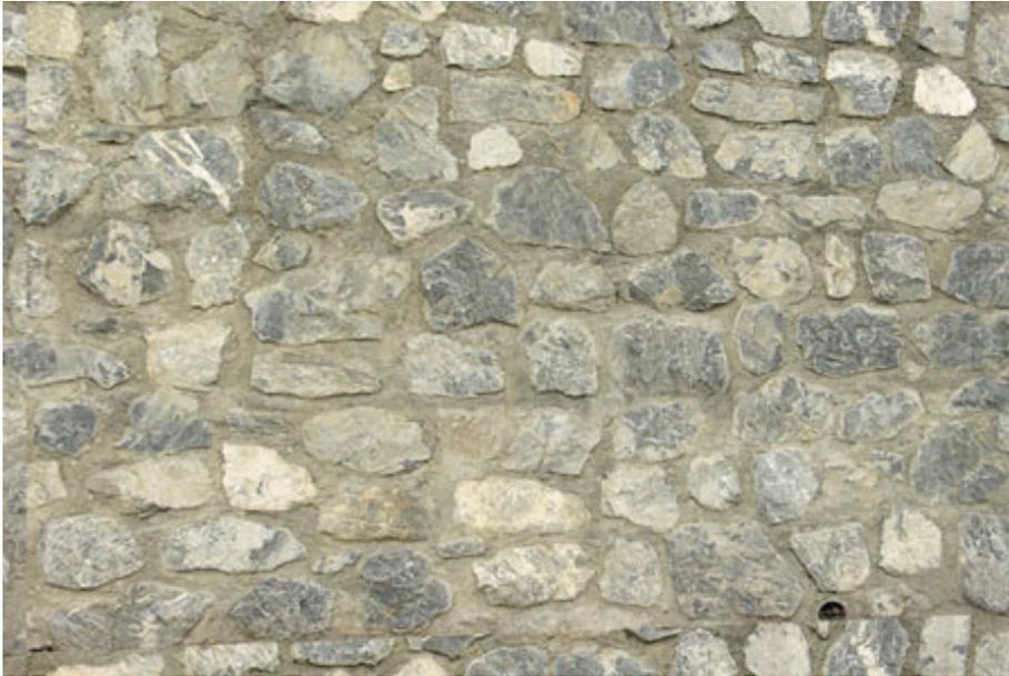
Un mur en bloc de maçonnerie de 8 pouces avec placage extérieur de 4 pouces d'épaisseur en pierres de type roche fendue coulé dans le mortier. La pierre de type roche fendue fait référence à une pierre qui a été séparée d'un bloc plutôt que sciée. Convient à des éléments de murs extérieurs tels que de nombreuses ouvertures et formes de coins, fenêtres et portes, typiques des maisons haut de gamme.
