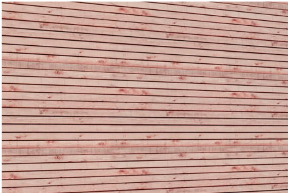
rives bouvetées, parement en bois de clin chevauché ou biseauté, puis disposé horizontalement ou verticalement sur le mur extérieur. Convient à des éléments de murs extérieurs tels que de nombreuses ouvertures et formes de coins, fenêtres et portes, typiques des maisons haut de gamme. Peut également contenir du bois principalement pâle et sans nœuds.
