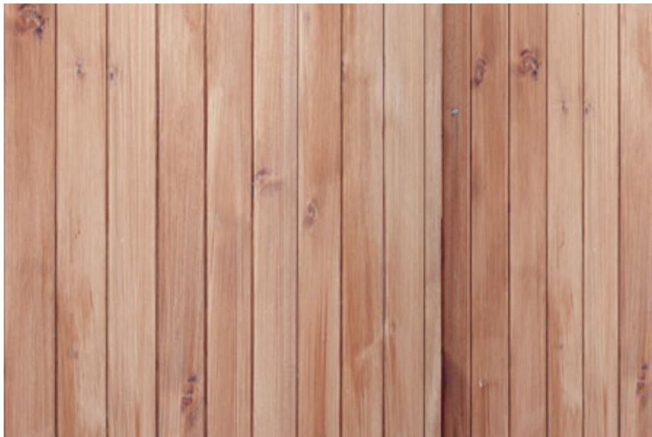
Parement en madrier rustique usiné sur mesure de 1 ¼ po x 12 po posé verticalement sur le mur extérieur. Les couleurs sont généralement un rouge délavé, un gris argent ou un brun riche peu commun. Convient à des éléments de murs extérieurs tels que de nombreuses ouvertures et formes de coins, fenêtres et portes, typiques des maisons haut de gamme. Peut également contenir du bois principalement pâle et sans nœuds.
