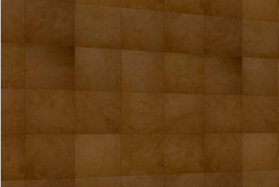
Parement de pierre brun-rouge ou brun foncé d'une épaisseur de 4 pouces, maintenu par du mortier et appliqué sur une charpente en bois. Convient à des éléments de murs extérieurs tels que de nombreuses ouvertures et formes de coins, fenêtres et portes, typiques des maisons haut de gamme. On le trouve principalement dans l'est des États-Unis.
