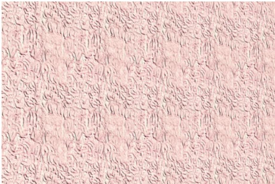
Un plâtre de ciment peint, de qualité supérieure, utilisé comme fini de surface d'un mur extérieur et généralement appliqué à un lattis métallique fixé à un colombage. Le plâtre est composé de ciment Portland, de chaux, de sable et d'eau. Convient à des éléments de murs extérieurs tels que de nombreuses ouvertures et formes de coins, fenêtres et portes, typiques des maisons haut de gamme.
