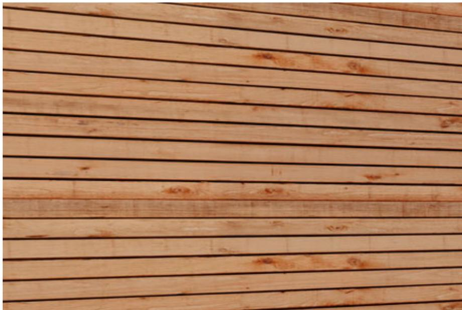
Parement en séquoia appliqué horizontalement avec le grain dans le sens de la longueur sur le mur extérieur. Les planches débitées sur quartier deviennent plus fines pour chevaucher la section la plus épaisse dans la partie inférieure. Convient à des éléments de murs extérieurs tels que de nombreuses ouvertures et formes de coins, fenêtres et portes, typiques des maisons haut de gamme. Peut également contenir du bois principalement pâle et sans nœuds.
