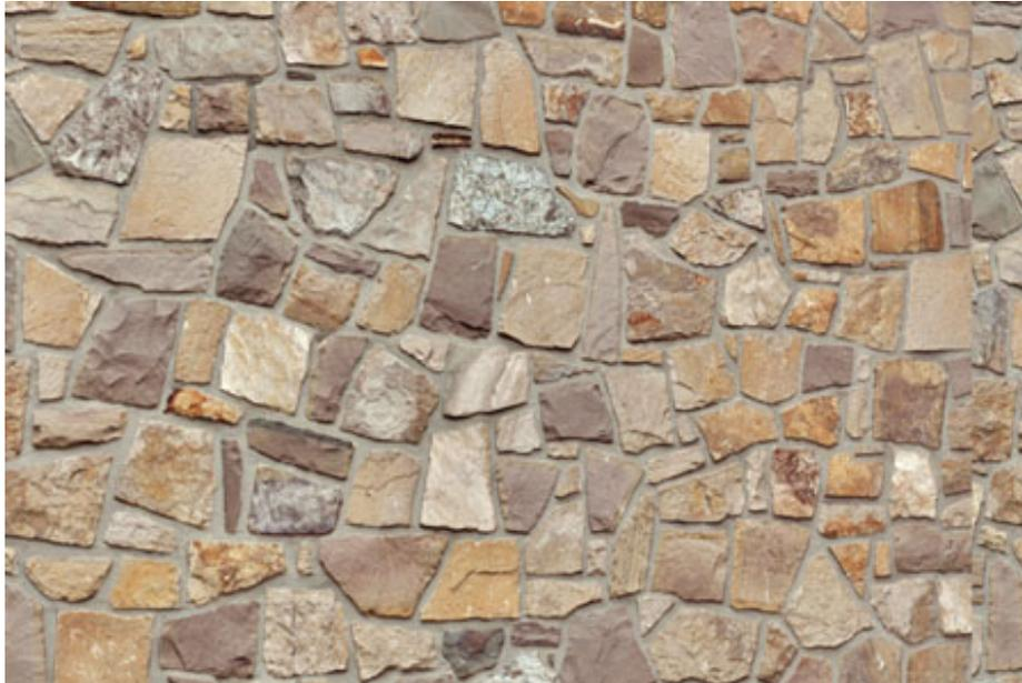
Un mur en bloc de maçonnerie de 8 pouces avec placage extérieur de 4 pouces d'épaisseur en pierres irrégulières appelées pierres des champs coulé dans le mortier. Convient à des éléments de murs extérieurs tels que de nombreuses ouvertures et formes de coins, fenêtres et portes, typiques des maisons haut de gamme.
