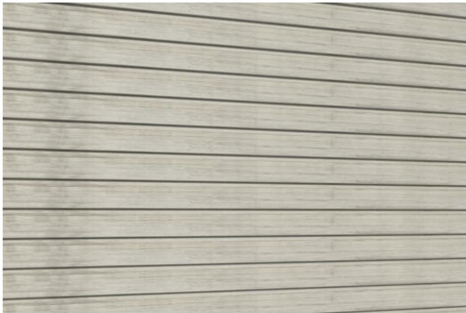
Parement fait de ciment, sable, fibre de cellulose et minéraux. On le trouve généralement en feuilles de 5/16 po d'épaisseur pour 12 po de longueur et 5 à 12 po de largeur. Le parement est disposé en couches superposées sur le châssis extérieur et généralement cloué sur le revêtement, par-dessus une couche de pare-vapeur. Le parement en fibre de ciment ressemble généralement à un parement en bois ou en clin traditionnel.
