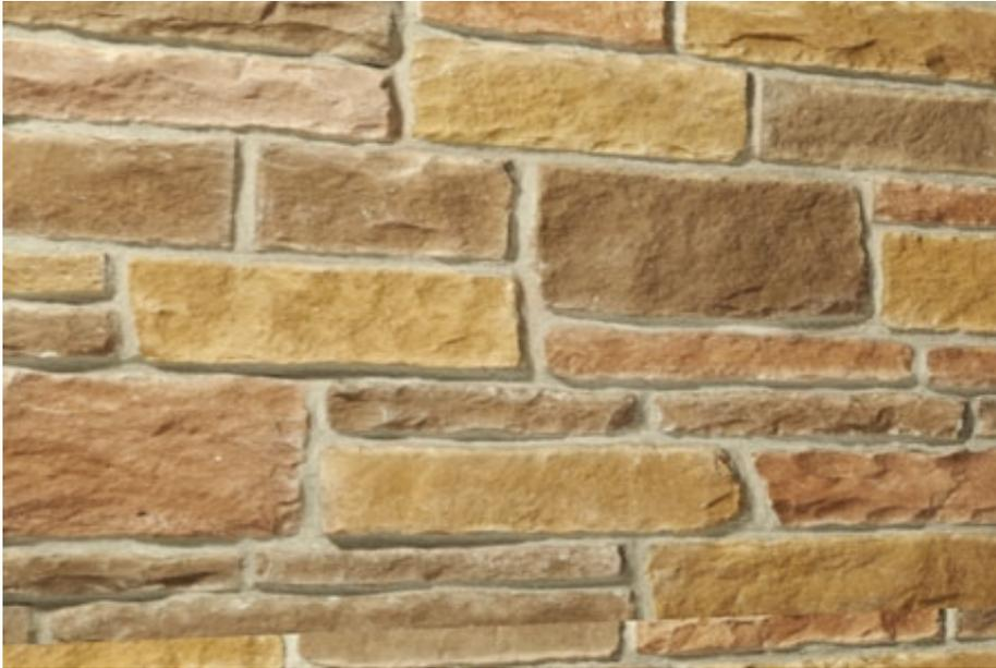
Un mur en blocs de maçonnerie de 8 pouces avec placage extérieur de 4 pouces d'épaisseur en pierres à surface plane coulé dans le mortier. La pierre à surface plane fait référence à la surface naturelle de la pierre taillée, offrant une apparence rustique et naturelle. Convient à des éléments de murs extérieurs tels que de nombreuses ouvertures et formes de coins, fenêtres et portes, typiques des maisons haut de gamme.
