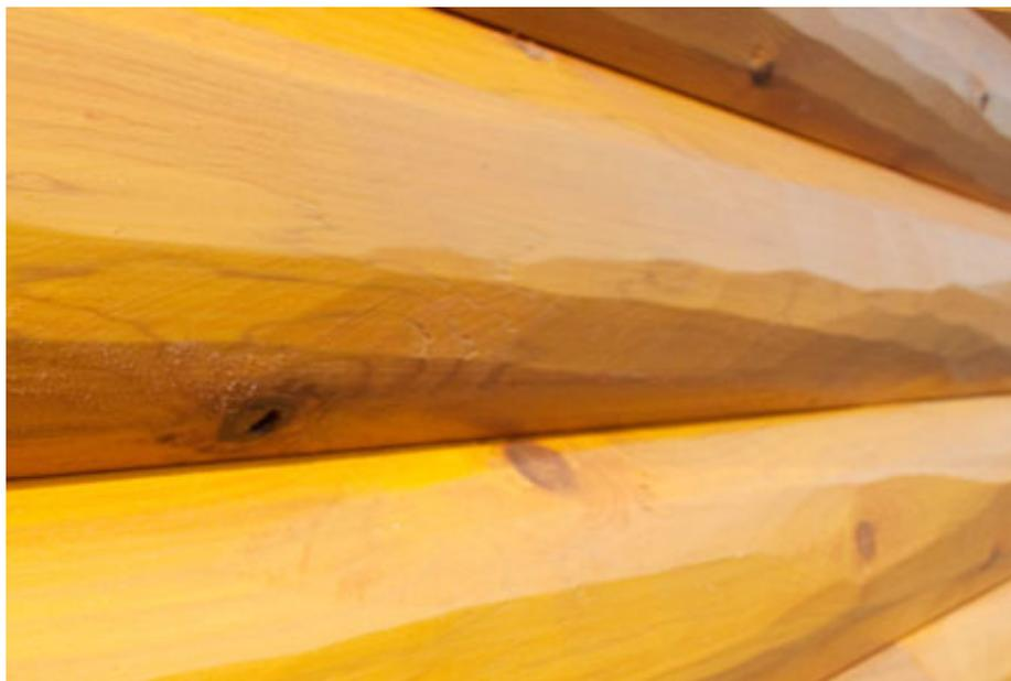
Murs faits d'un placage de rondins au fini taillé à la main de 8 po x 8 po empilés avec coins pleins. L'espace entre chaque rondin est calfeutré de façon à être étanche. Convient à des éléments de murs extérieurs tels que de nombreuses ouvertures et formes de coins, fenêtres et portes, typiques des maisons haut de gamme.
