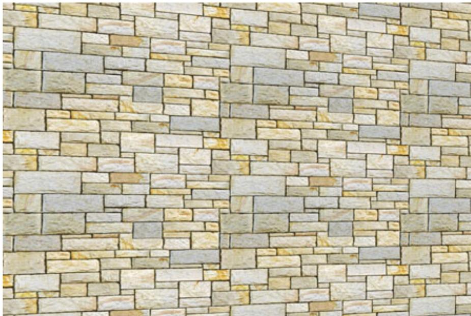
Placage de pierre calcaire de 4 pouces d'épaisseur (roche sédimentaire principalement composée de carbonate de calcium) appliqué sur une ossature en bois avec revêtement et isolation. Convient à des éléments de murs extérieurs tels que de nombreuses ouvertures et formes de coins, fenêtres et portes, typiques des maisons haut de gamme.
