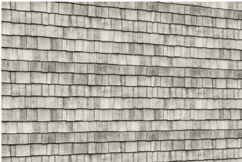
Faits de ciment, sable, fibre cellulosique et minéraux, les bardeaux sont formés de plaques de 0,25 po d'épaisseur, pour 18 po de longueur et 6 po à 12 po de largeur, disposées en couches superposées sur un mur extérieur en maçonnerie pleine (blocs ou béton coulé). Tient compte d'une conception de maison unique. Comprend les coins, la fenestration et les ouvertures uniques de fenêtre et de porte lors de la pose des matériaux de murs extérieurs. Peut aussi inclure des couleurs personnalisées.
