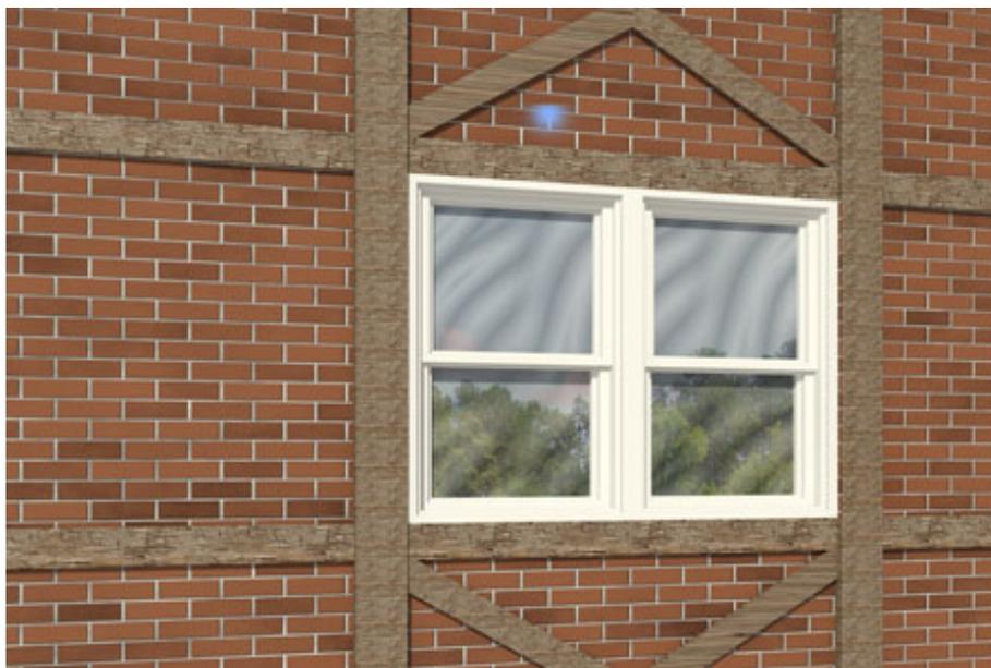
Brique sur mesure à face vernissée et boiserie de cèdre fixées à une structure à montants en métal ou en bois à l'aide de fixations murales. La brique n'est qu'ornementale, elle n'offre aucun support structural au bâtiment. Convient à des éléments de murs extérieurs tels que de nombreuses ouvertures et formes de coins, fenêtres et portes, typiques des maisons haut de gamme.
