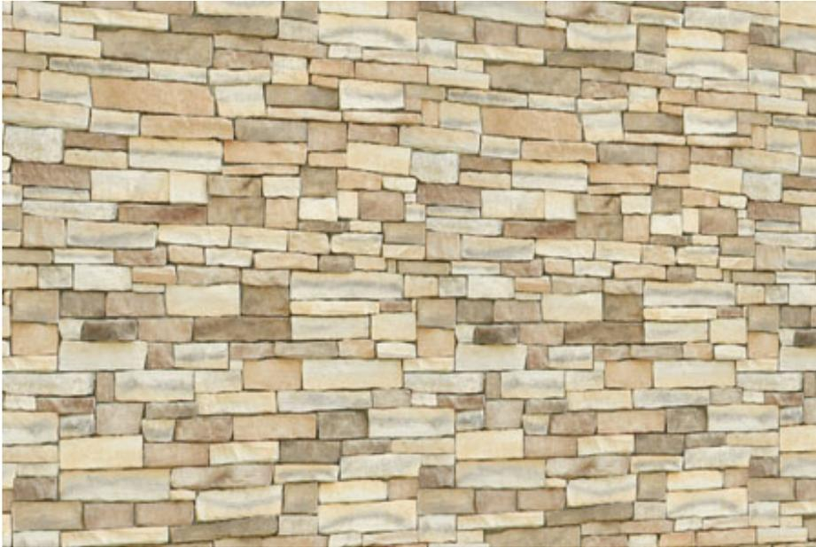
Placage de pierre comme le granit, la pierre des champs ou la pierre calcaire qu'on trouve dans les carrières, pour être ensuite ancré à un mur de bloc de maçonnerie. La pierre n'est qu'ornementale, elle n'offre aucun support structural au bâtiment. Convient à des éléments de murs extérieurs tels que de nombreuses ouvertures et formes de coins, fenêtres et portes, typiques des maisons haut de gamme. Peut aussi comprendre des couleurs et textures personnalisées.
