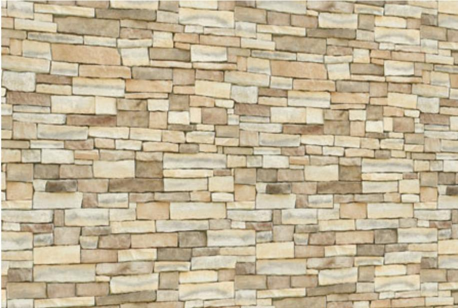
Placage de pierre comme le granit, la pierre des champs ou la pierre calcaire qu'on trouve dans les carrières et lié par mortier puis ancré à un mur à ossature. La pierre n'est qu'ornementale, elle n'offre aucun support structural au bâtiment. Convient à des éléments de murs extérieurs tels que de nombreuses ouvertures et formes de coins, fenêtres et portes, typiques des maisons haut de gamme. Peut aussi comprendre des couleurs et textures personnalisées.
