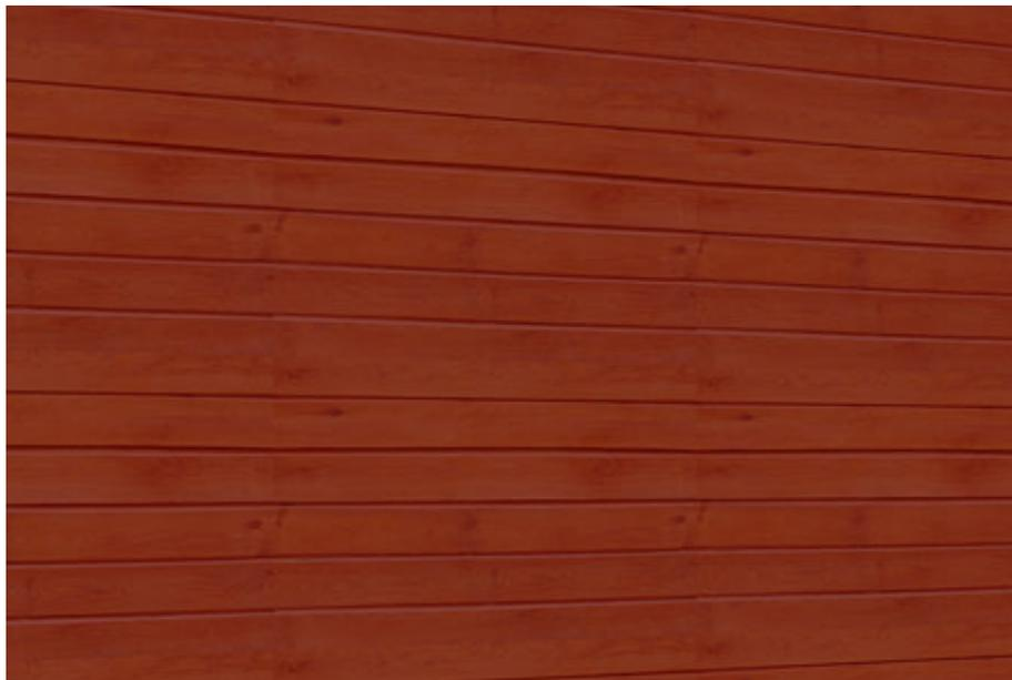
Parement de panneaux durs en composite biseauté ou chevauché disposé horizontalement ou verticalement sur le mur extérieur. Le panneau dur est fait de fibres de bois pressées ou de fibres de bois collées avec des résines et façonnées à la chaleur et à la pression en un modèle particulier. On le connaît aussi sous le nom de Masonite. Convient à des éléments de murs extérieurs tels que de nombreuses ouvertures et formes de coins, fenêtres et portes, typiques des maisons haut de gamme.
