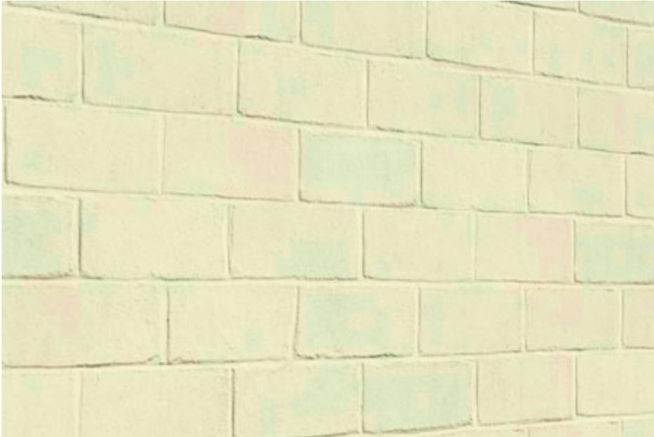
Mur en bloc de maçonnerie plein, au fini peint. Convient à des éléments de murs extérieurs tels que de nombreuses ouvertures et formes de coins, fenêtres et portes, typiques des maisons haut de gamme.
