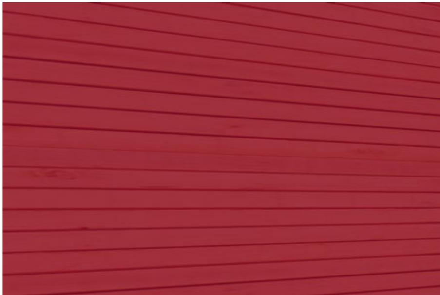
Parement en bois dur disposé de façon à se chevaucher ou en biseau, horizontalement ou verticalement sur le mur extérieur (bloc de béton ou béton coulé). Tient compte d'une conception de maison unique. Comprend les coins, la fenestration et les ouvertures uniques de fenêtre et de porte lors de la pose des matériaux de murs extérieurs. Peut aussi inclure des couleurs personnalisées.
