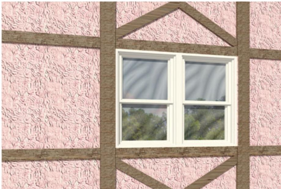
Mur extérieur fait d'une ossature en bois avec stuc et boiserie de cèdre. Un plâtre au ciment utilisé comme fini de surface d'un mur extérieur et généralement appliqué à un lattis métallique fixé à une base de mur et assorti d'une boiserie en cèdre. Le plâtre est composé de ciment Portland, de chaux, de sable et d'eau. Convient à des éléments de murs extérieurs tels que de nombreuses ouvertures et formes de coins, fenêtres et portes, typiques des maisons haut de gamme.
