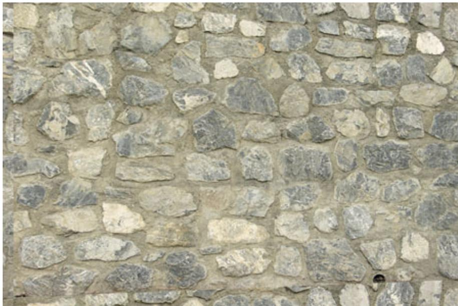
Un placage de pierre de type roche fendue de 4 pouces d'épaisseur plâtré et ancré à un mur de charpente. La pierre de type roche fendue fait référence à une pierre qui a été séparée d'un bloc plutôt que sciée. Convient à des éléments de murs extérieurs tels que de nombreuses ouvertures et formes de coins, fenêtres et portes, typiques des maisons haut de gamme.
