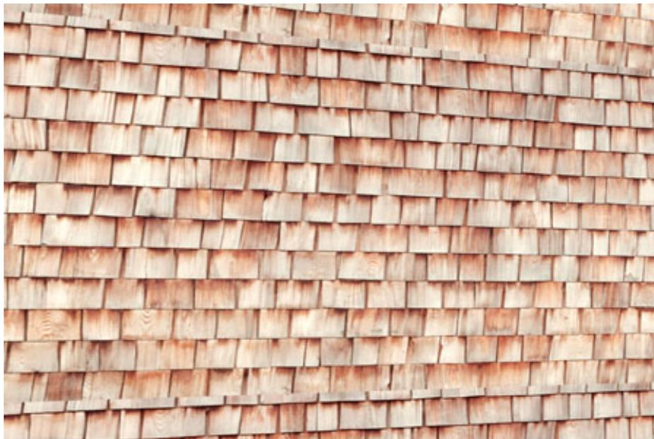
Bardeaux en pin de Nouvelle-Angleterre disposés en couches superposées sur le cadre extérieur. La plupart des paquets de bardeaux sont offerts en différentes largeurs et appliqués par-dessus le revêtement et le pare-vapeur. Convient à des éléments de murs extérieurs tels que de nombreuses ouvertures et formes de coins, fenêtres et portes, typiques des maisons haut de gamme. Peut aussi comprendre des bardeaux haute qualité coupés sur mesure.
