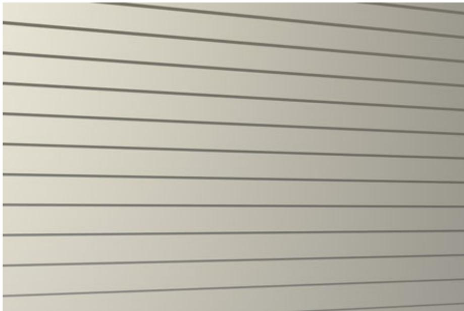
Parement en aluminium disposé de façon à se chevaucher ou en biseau, horizontalement ou verticalement sur le mur extérieur (bloc de béton ou béton coulé). Tient compte d'une conception de maison unique. Comprend les coins, la fenestration et les ouvertures uniques de fenêtre et de porte lors de la pose des matériaux de murs extérieurs. Peut aussi inclure des couleurs personnalisées.
