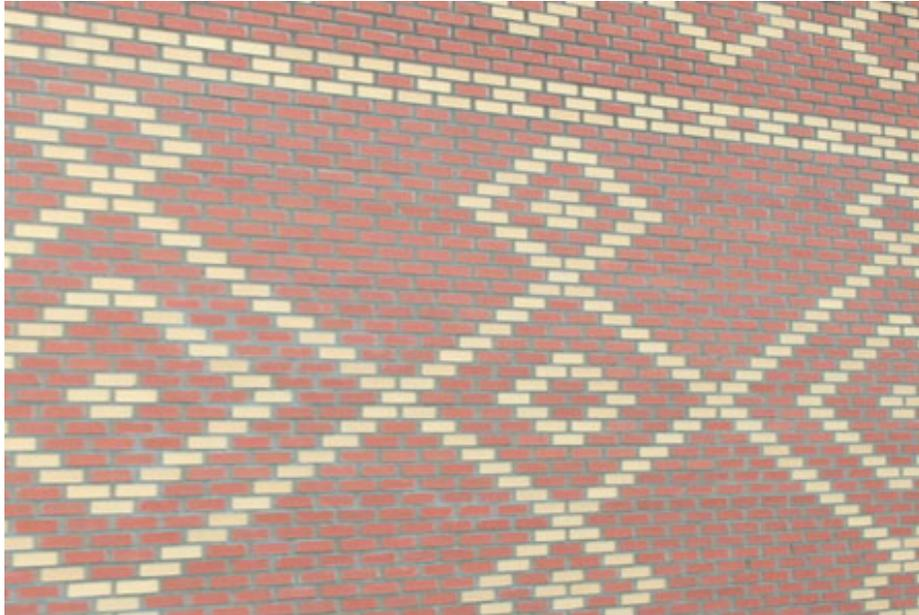
Brique à face vernissée de haute qualité fixées par maçonnerie à des blocs de béton armé ou à un mur de renforcement en maçonnerie. La brique n'est qu'ornementale, elle n'offre aucun support structural au bâtiment. Convient à des éléments de murs extérieurs tels que de nombreuses ouvertures et formes de coins, fenêtres et portes, typiques des maisons haut de gamme. Peut aussi comprendre des couleurs et textures personnalisées.
