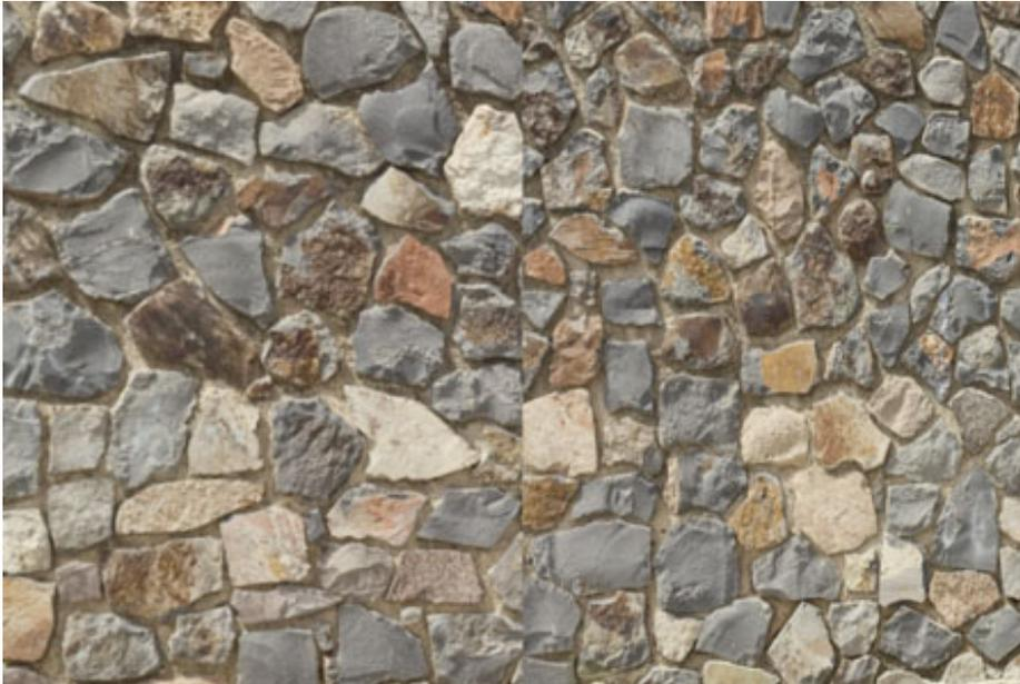
Un mur en blocs de maçonnerie de 8 pouces avec placage de granit pâle de texture grossière coulé dans le mortier à l'extérieur. Convient à des éléments de murs extérieurs tels que de nombreuses ouvertures et formes de coins, fenêtres et portes, typiques des maisons haut de gamme.
