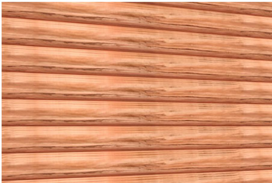
Murs faits d'un placage de rondins en bois surdimensionnés de 6 po x 12 po empilés avec coins pleins. L'espace entre chaque rondin est calfeutré de façon à être étanche. Convient à des éléments de murs extérieurs tels que de nombreuses ouvertures et formes de coins, fenêtres et portes, typiques des maisons haut de gamme.
