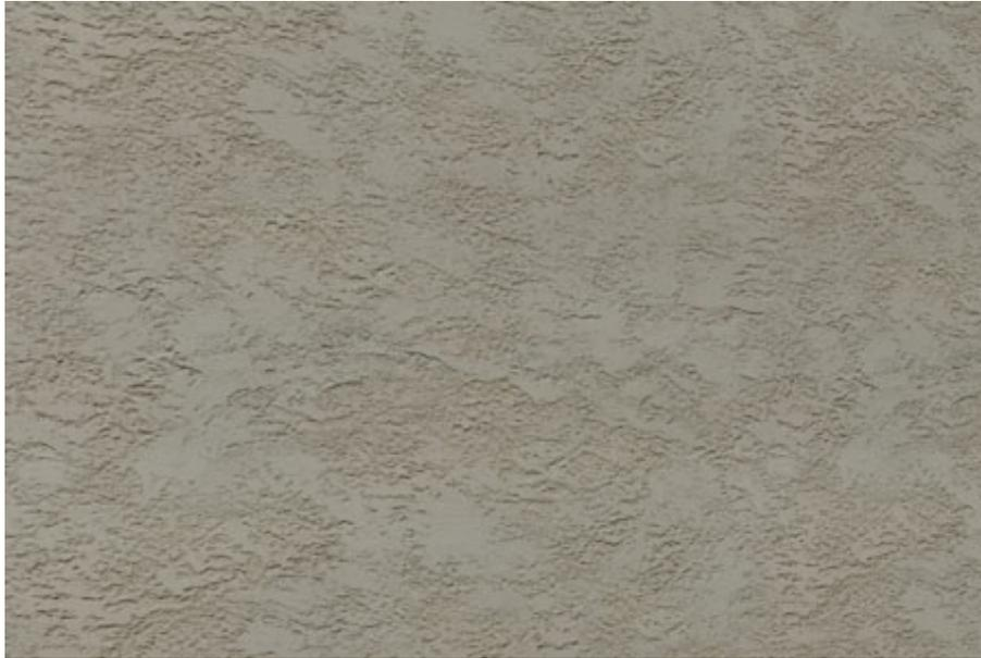
Cloison intérieure constituée de blocs de maçonnerie plâtrés avec 2 couches de stucco, peints puis scellés pour fournir une surface lisse pour permettre l'application d'un fini. Convient à des éléments de cloisonnement uniques tels que de nombreux angles, coins, ouvertures, arches et autres configurations complexes.
