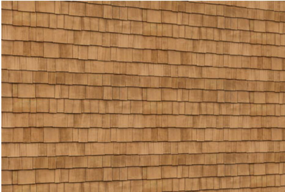
Bardeaux de pin de la Nouvelle-Angleterre disposés selon un motif superposé sur un mur extérieur en maçonnerie pleine (blocs ou béton coulé).
