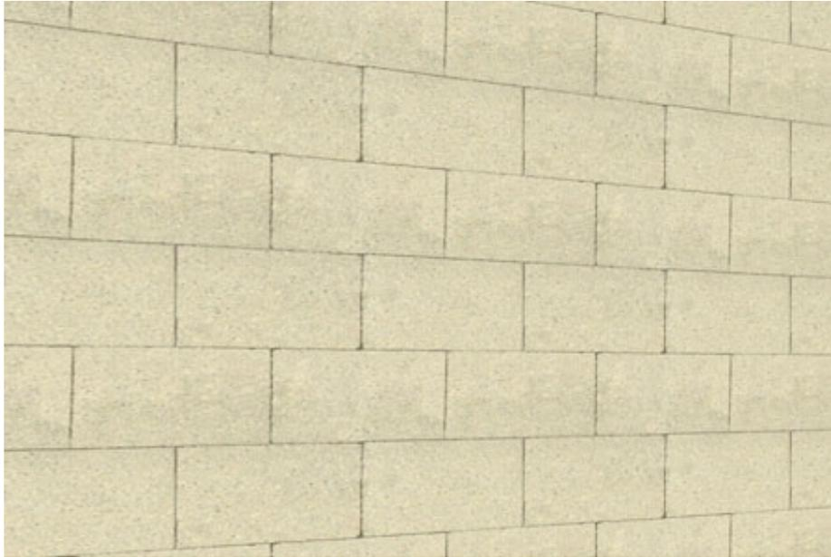
Un mur en blocs de maçonnerie fabriqué à partir de briques en béton creuses avec renforts coulés dans le mortier. Convient à des éléments de murs extérieurs tels que de nombreuses ouvertures et formes de coins, fenêtres et portes, typiques des maisons haut de gamme.
